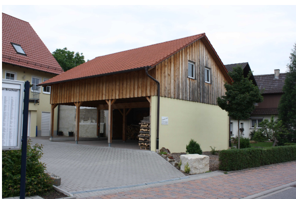
Kurpfalzstraße 54, Abbruch Wohnhaus zur Entkernung und Schaffung von Stellplätzen
