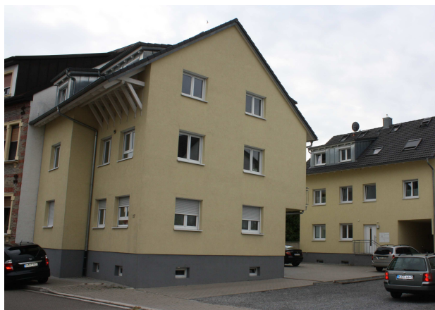
Kurpfalzstraße 27, Abbruch Wohnhaus und Scheune zur Wohnbauung
