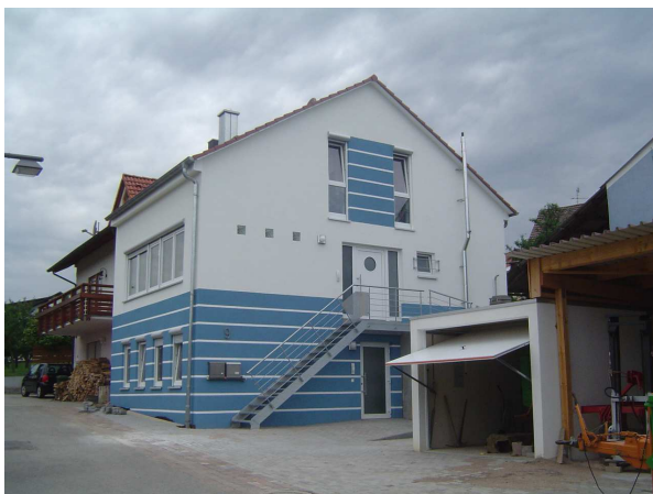
Eberhardstraße 9, Abbruch Scheune zur Neubauung
