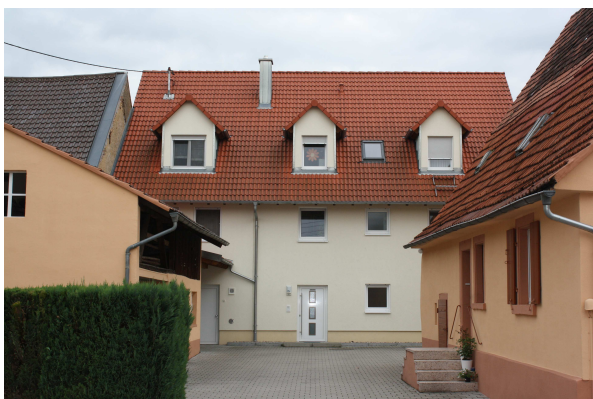
Kurpfalzstraße 61, Abbruch Scheune zur Neubauung
