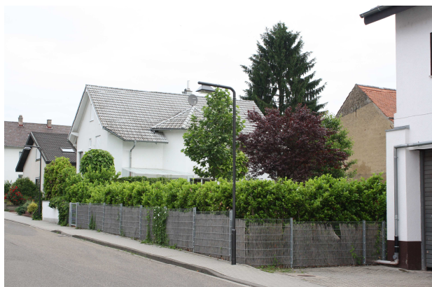
Kurpfalzstraße 36, Abbruch Scheune zur Entkernung
