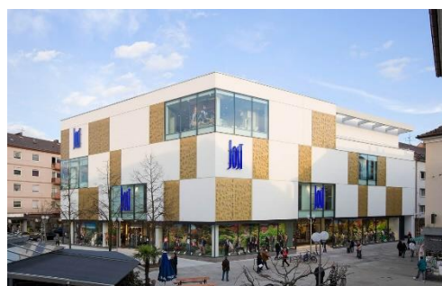
Energetische Erneuerung Modehaus Jost
