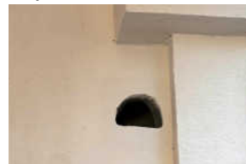
Halbhöhlenkasten im Mauerwerk
