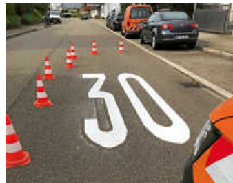
Markierungsarbeiten an der Württemberger Straße sind abgeschlossen Foto: Alina Kurth
