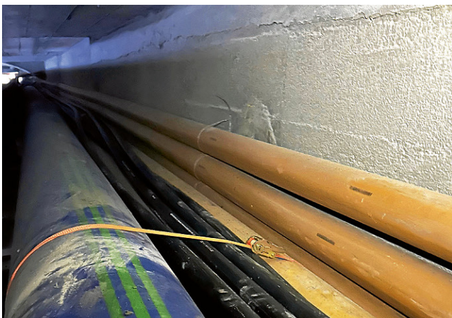
Im Bild, das während der Baumaßnahme entstanden ist, die Wasserleitung (blau), die Schutzrohre (gelb) sowie die bereits vorhandenen Lichtwellenleiter-Leitungen (schwarz)
