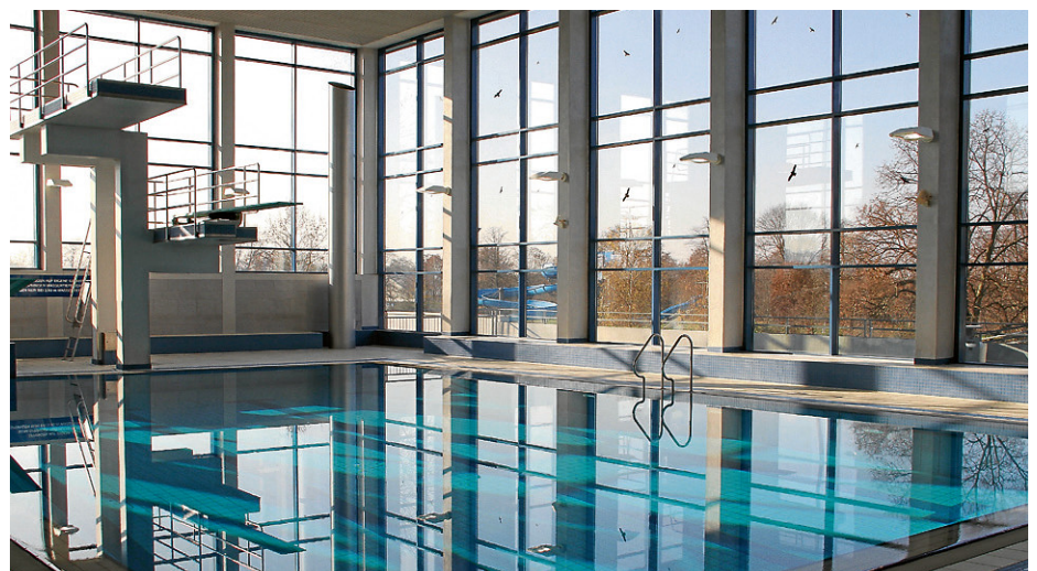
Auf Basis der Sachverständigen-Gutachten der Betonprüfstelle und eines Statikbüros haben sich die Stadtwerke Bruchsal entschieden, den Sprungturm im SaSch!-Hallenbad vorläufig wieder freizugeben
