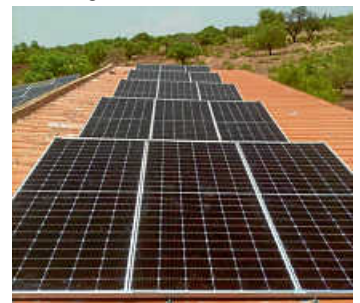
Letzte Woche wurde bei 38°C die neue Solaranlage zur Stromversorgung auf unsere Lehrwerkstatt in Burkina Faso/Afrika montiert
