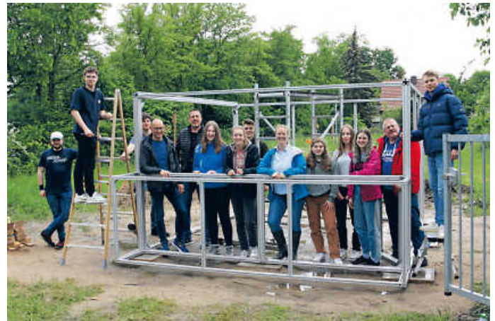
Bau des Gewächshauses
