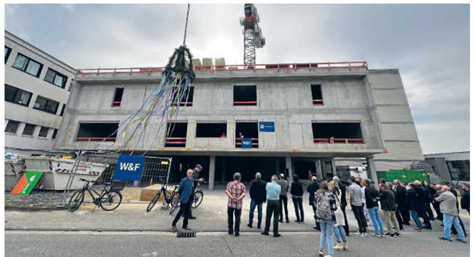
Für insgesamt 100 Millionen Euro entsteht ein neuer OP-Trakt am Standort
