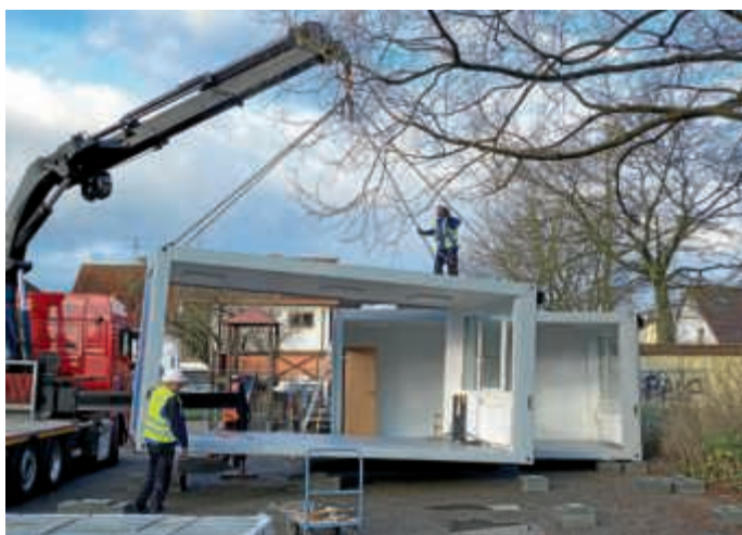
Die Container wurden auf dem Römerplatz aufgebaut
