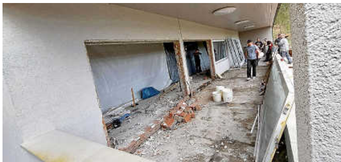
Der FCO hat wieder eine Großbaustelle
