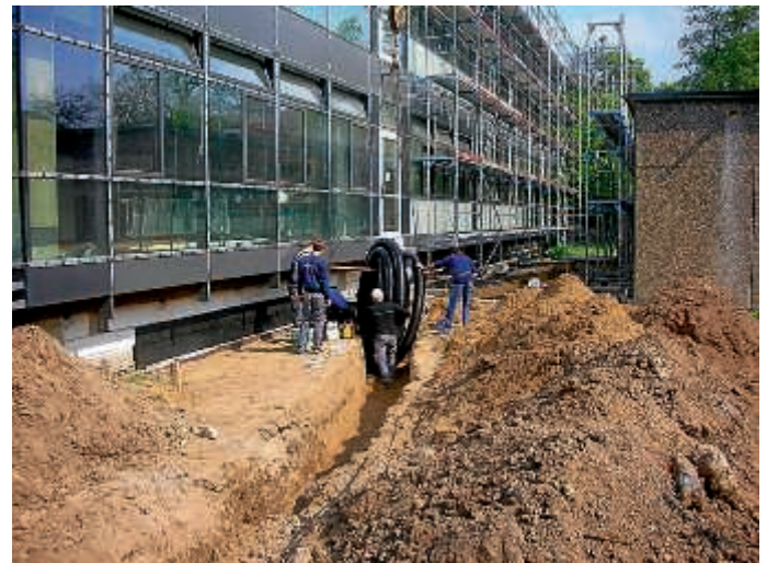
Sanierung der Hebelschule
