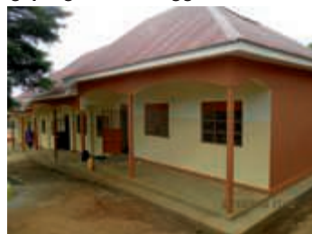
Der fertiggestellte Erweiterungsbau der St. Ben Schule Foto: Konvoi
