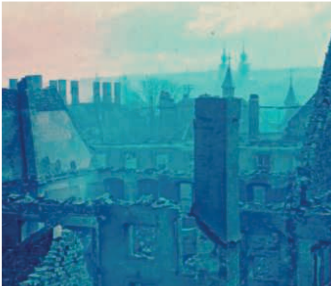
Fast 80 Prozent der Bruchsaler Innenstadt wurde zerstört.
