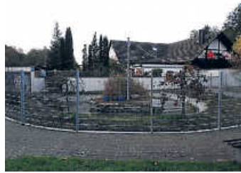
Die Renovierung hat begonnen Foto: S. Brekl
