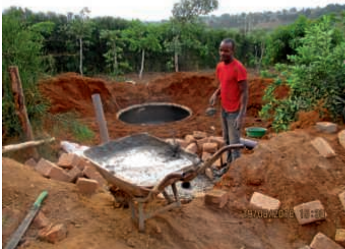
Kyamulibwa: Die Arbeiten an der Biogasanlage gehen gut voran.
