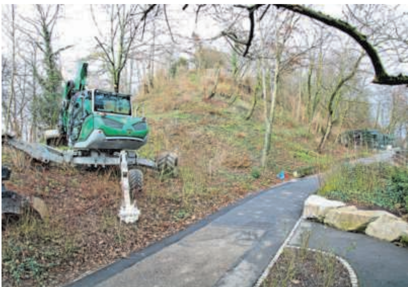
Das neue Gehege soll naturnah sein und den Luchsen viel Abwechslung bieten. Für die Erdarbeiten an den Steilhängen ist ein Schreitbagger notwendig. Fotos: Zoo Karlsruhe
