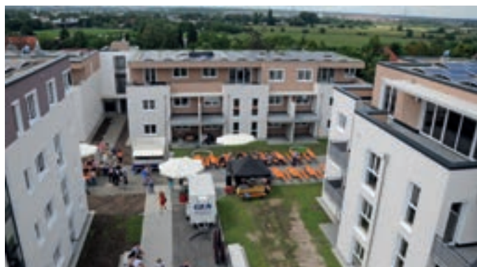
Die Wohnanlage Peter Frank Karree umfasst 65 Wohnungen auf rund 5.000 Quadratmetern, die zusätzlich über Fotovoltaik-Module auf den Dächern und einem Blockheizkraftwerk versorgt werden. Foto: Maske
