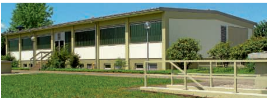
Im Heildensheimer Wasserwerk haben die Stadtwerke in den vergangenen Monaten mit Hochdruck an der neuen Teilentsalzungsanlage nach dem Umkehrosmoseverfahren gearbeitet. Fotos: jw/tw
