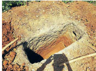
Erste Erdbewegungen zum Bau der Klinik
