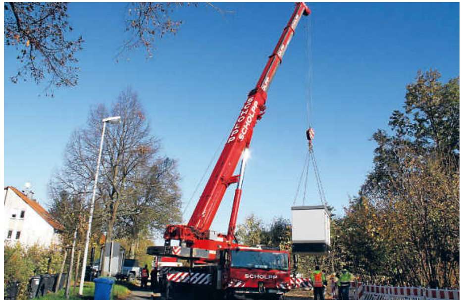
Mit dem großen Mobilkran sieht das Einheben der tonnenschweren Trafostation spielend leicht aus.
