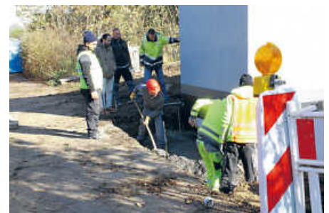
Mit einigen Schaufeln Split wird auf Wunsch des Projektleiters der minimale Höhenunterschied noch nivelliert
