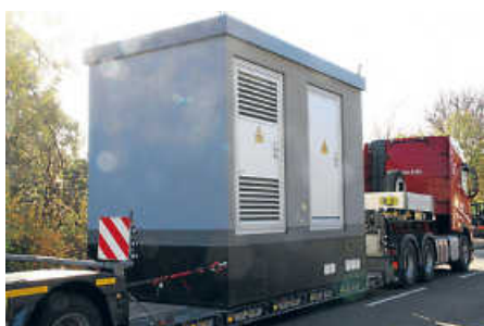
Zunächst wird die Trafostation mit einem Tieflader an ihren Bestimmungsort transportiert.
