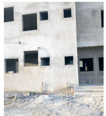
Der Außenputz unserer Klinik in Burkina Faso/Afrika ist fast abgeschlossen Foto: T. Nakelisse
