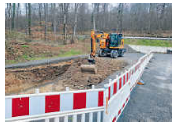
Baugrube für die neue Zisterne
