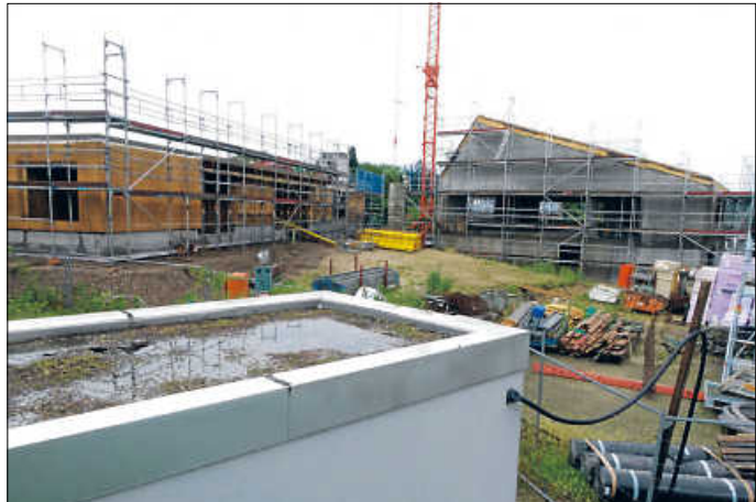
Hier soll ein Treffpunkt für Heidelberg entstehen: Kindergarten (links) und Gemeindehaus (beide noch im Rohbau) mit Vorplatz Foto: PM
