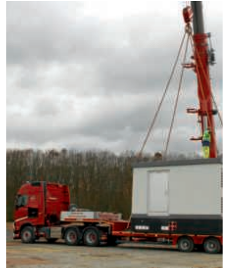
Am 19. November wurde die Trafostation für die PV-Freiflächenanlage per Schwerlastkran eingehoben ...
