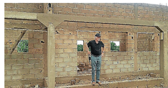
Dr. Rolf Pflücke auf Inspektionsreise beim Schulbau in Sandogo/Burkina Faso. Foto: Konvoi der Hoffnung
