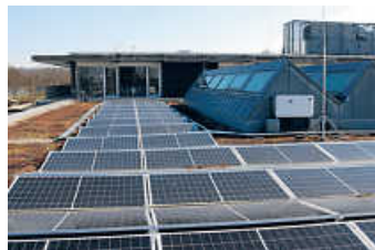
Dachansicht des HBG Foto: HBG
