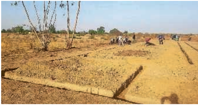
Bei den Ausschachtungsarbeiten tragen die Bewohner ihren Eigenanteil bei Foto: konvoi
