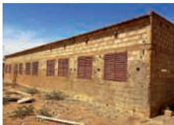
Schulgebäude 1 vor dem Verputzen (hintere Ansicht) Foto: pr
