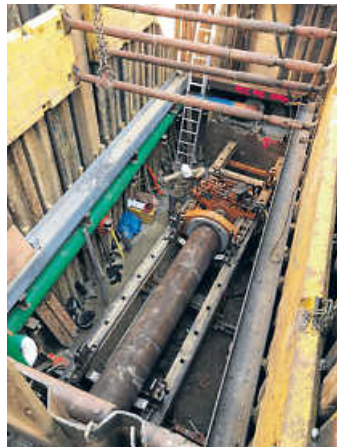
Derzeit werden Kanalbauarbeiten in Untergrombach durchgeführt Foto: PM
