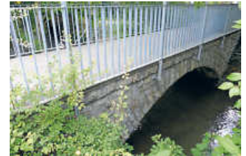
Bestehende Brücke über den Saalbach Foto: Gölz
