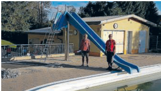
Vorstände Uwe und Achim an der Baustelle zur Rutschensicherung
