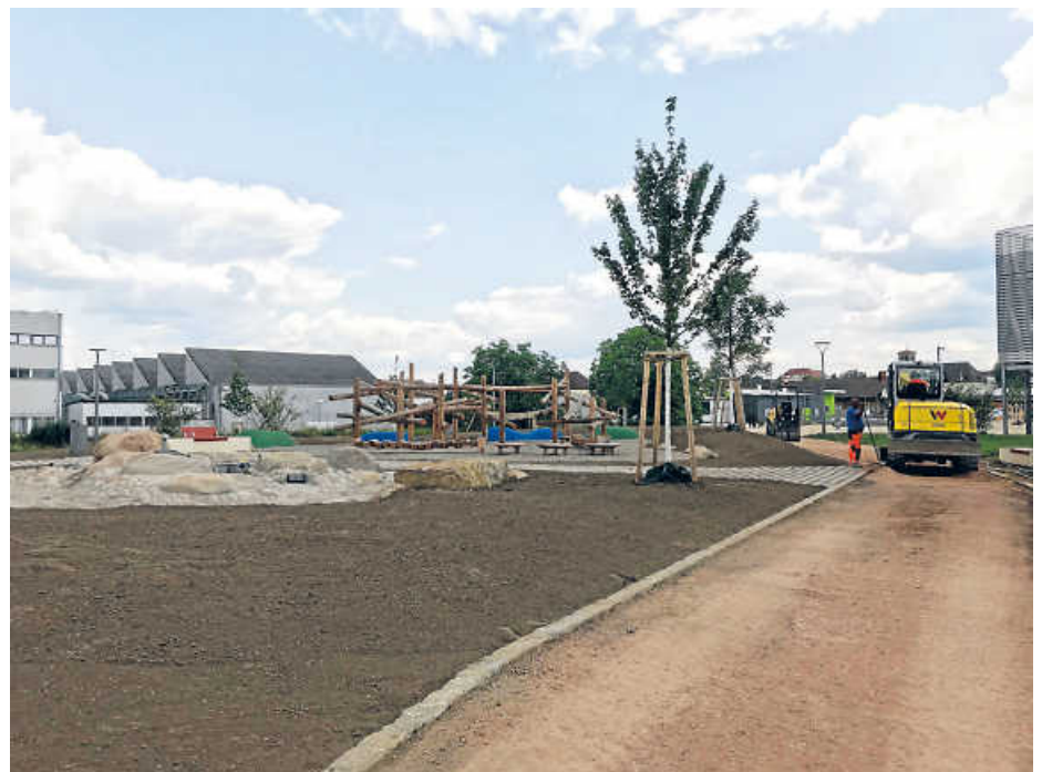
Die Arbeiten für den Quartiersplatz sind im vollen Gange
