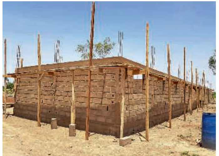
Hinteransicht: Gerüst zum Mauern des Kniestocks fehlt noch
