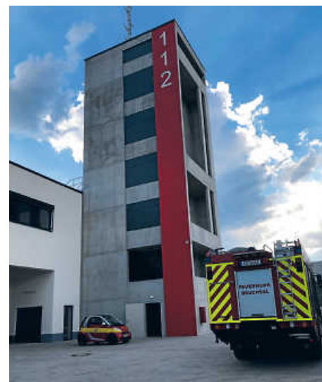
Die einheitliche Notrufnummer 112, hier auf dem Turm des neuen Feuerwehrhaus
