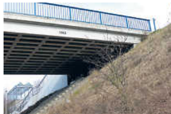
Die Brücke aus dem Jahr 1963 ersetzte zwei Bahnübergänge
