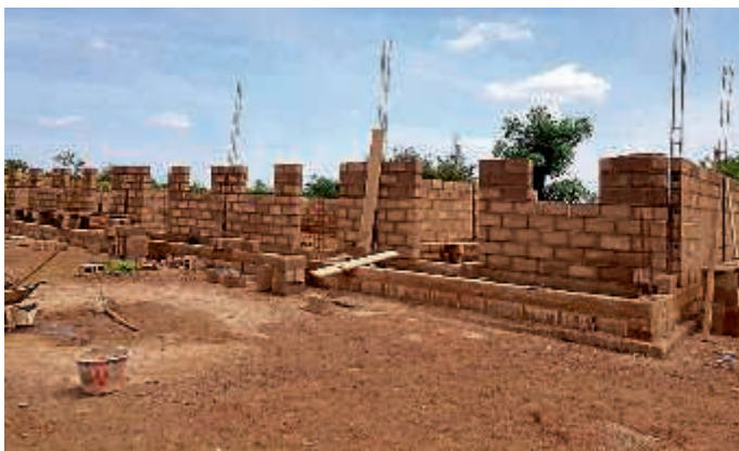
Schneller Baufortschritt bei der Berufsschule in Sourgoubila/Afrika.
