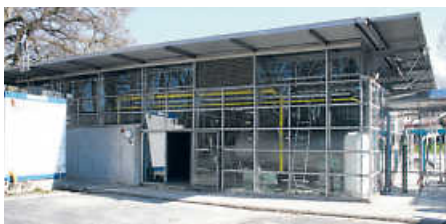
Die denkmalgeschützte Heizzentrale des Gewerblichen Bildungszentrums.
