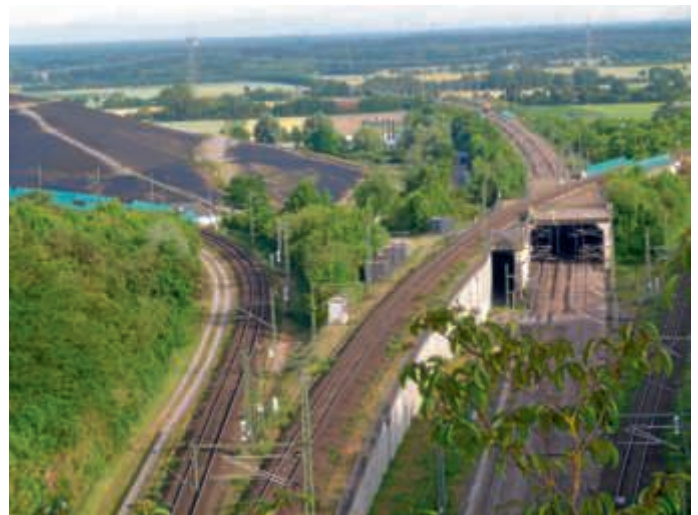
Auf der Schnellfahrstrecke fahren derzeit keine Züge, dafür umso mehr auf den Ausweichstrecken
