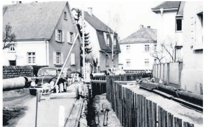
Büchenau vor 50 Jahren: Kanalisationsarbeiten 1967 auf der damaligen Hauptstraße unweit der Abzweigung der Spöcker Straße
