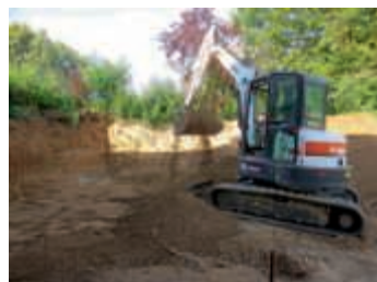
Sven Rummel beim Ausbaggern Foto: pr.
