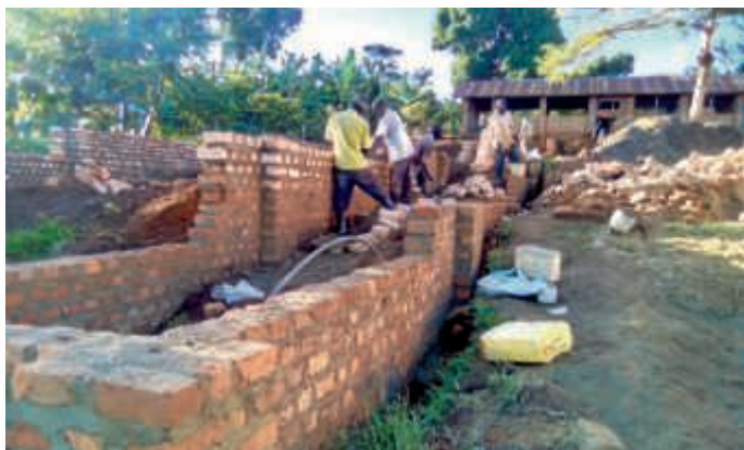
Uganda: Schulneubau und Renovierung machen Fortschritte
