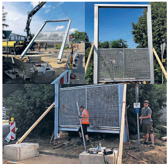
Aufbau Werbemastanlage
