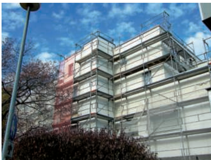
Im Sanierungsfahrplan wird der aktuelle energetische Zustand des Gebäudes analysiert. Foto: Umweltstelle
