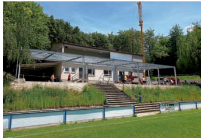
Neu errichtetes Vordach
