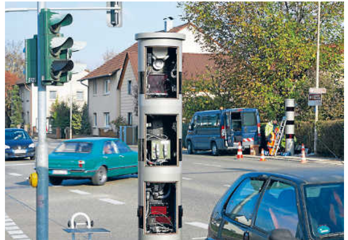
Die neue Blitzanlage ist in Betrieb
