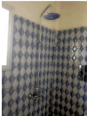
Die sanitäre Einrichtung (Duschen, WCs, Waschbecken) ist komplett installiert Foto: M. Regma
