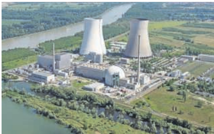
Der Block 2 des Kernkraftwerks Philippsburg ist seit dem 15. Mai 2017 wieder am Netz. Foto: EnBW AG
