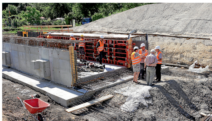
Thomas Huber von der Firma Grötz erläutert Oberbürgermeisterin Cornelia Petzold-Schick und Bauamtsleiter Willi Guth (rechts) den Fortschritt der Bauarbeiten am Schattengraben. Foto: pa
