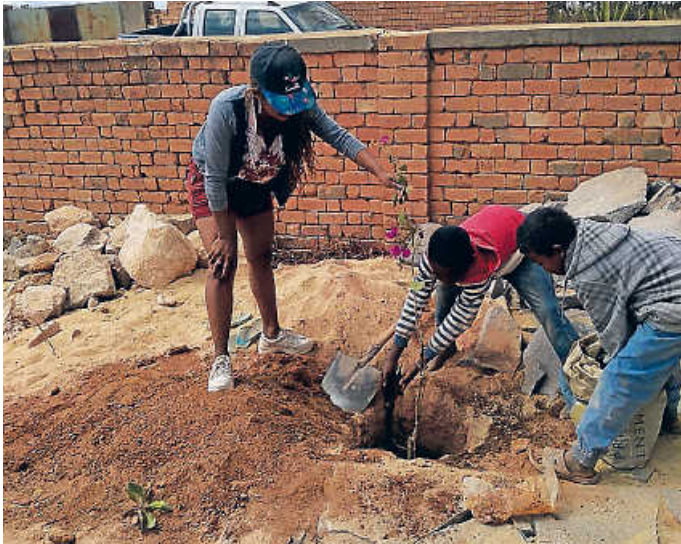
Brunnenbau hat begonnen
