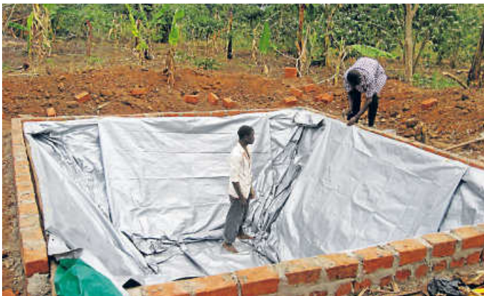
Bau eines einfachen Wasserreservoirs zur Bewässerung
