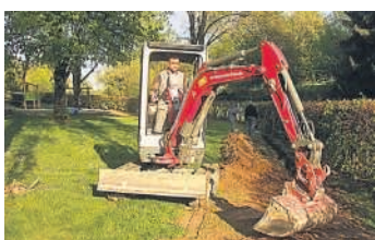
Christian Janzer mit Sohn Jonathan bei Baggerarbeiten für die neue Wasserleitung Foto: B.K.
