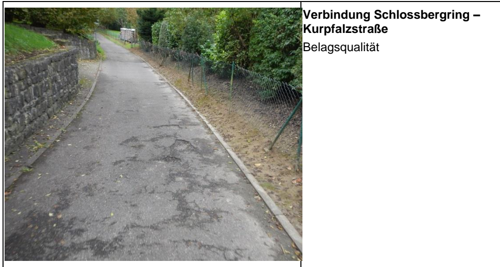
Abb. 3.1: Beispiele für Mängel an Radverkehrsanlagen in Bruchsal
