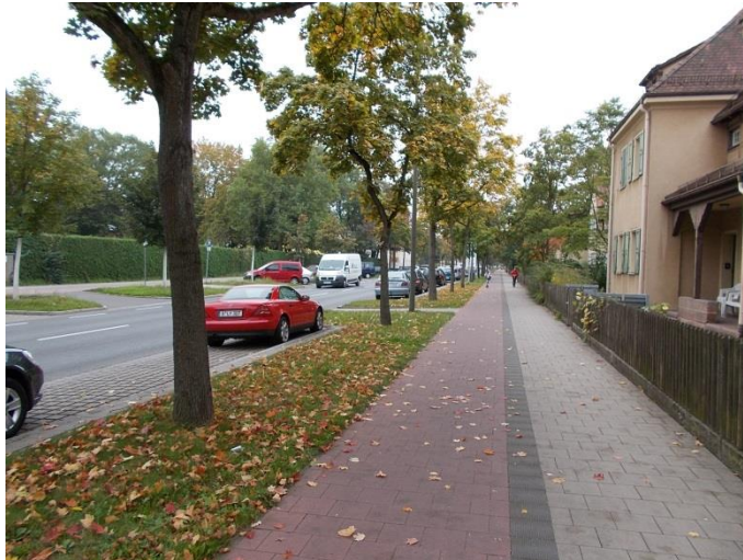
Abb. 5.12 Baulicher Radweg in Erlangen - rotes Pflaster mit grauer Einfassung
