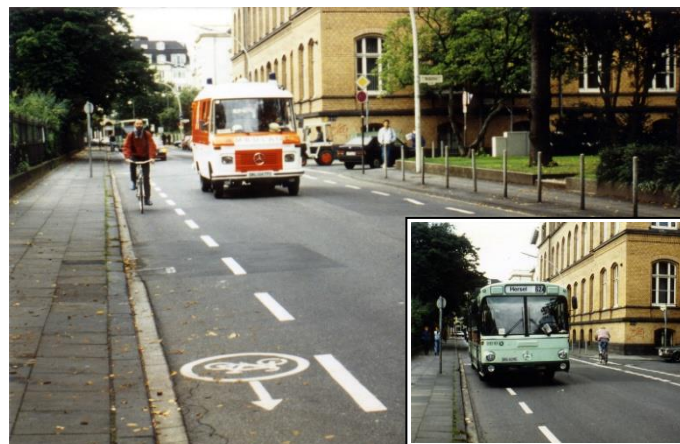
Abb. 4.6 Schutzstreifen als Schonraum für Radfahrer und als „Reservefläche“ für große Fahrzeuge (Bonn)
