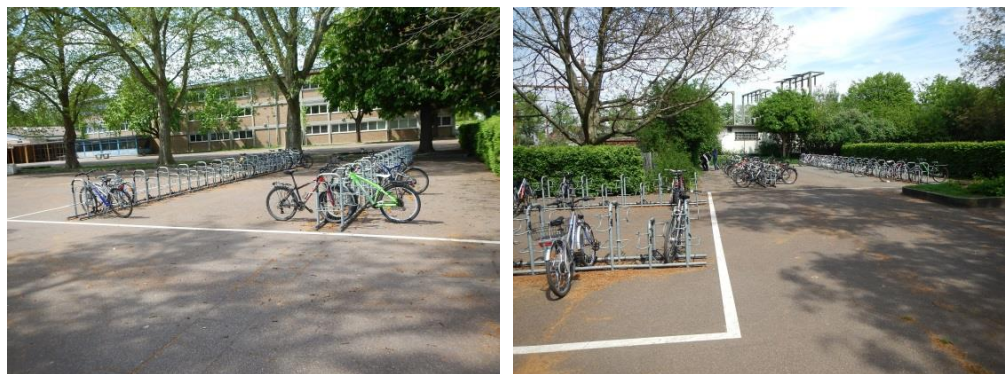
Abb. 8.20: Gemeinsame Abstellanlage der Albert-Schweitzer- und der Pestalozzischule
