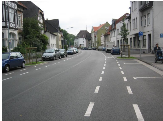
Abb. 4.7 Schutzstreifen mit Sicherheitstrennstreifen zu parkenden Kfz (Lemgo)
