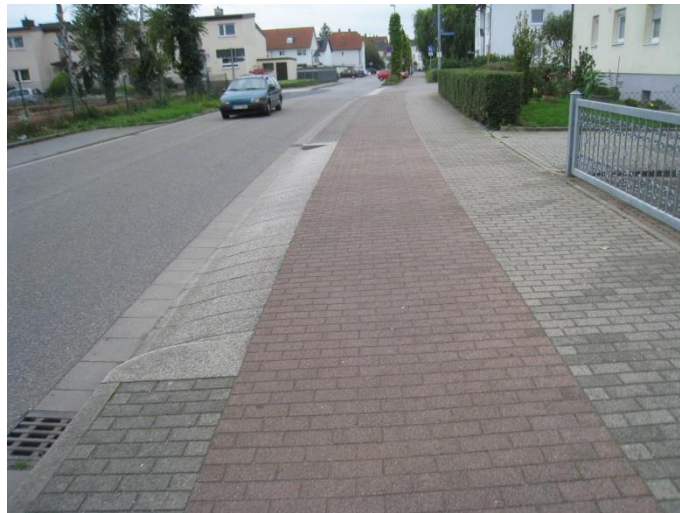
Abb. 5.8 Baulicher Radweg im Zuge der Schwetzingen Straße
