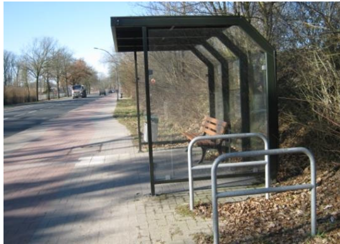
Abb. 8.29: Beispiel einer Bushaltestelle mit Abstellanlage in Rotenburg (Wümme)
