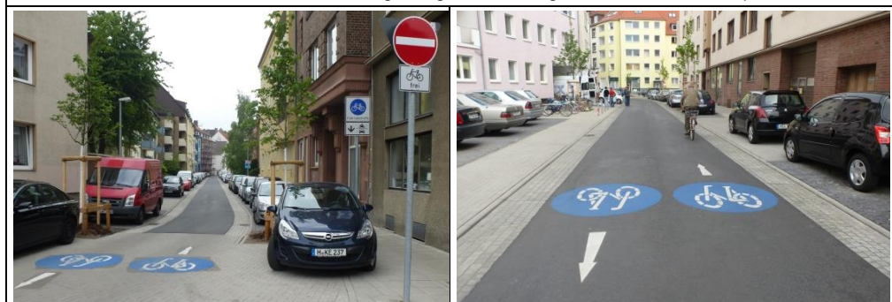
Beispiel Hannover Runde Piktogramme in Blau und Richtungspfeile im Straßenverlauf. Die Rinnen zwischen der asphaltierten Fahrbahn und den Parkständen sind farblich abgesetzt gepflastert und dienen als Sicherheitstrennstreifen.
