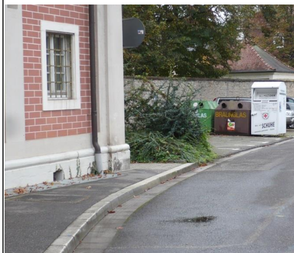
Am Damianstor Fehlende Bordabsenkung
