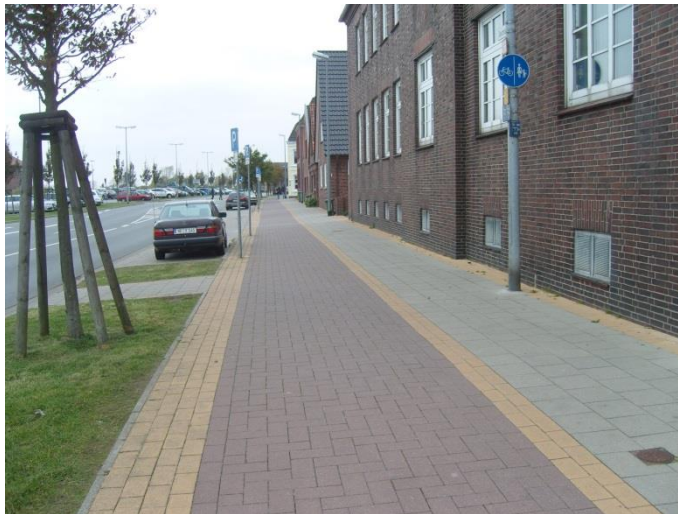
Abb. 5.11 Baulicher Radweg in Husum (Schleswig-Holstein) - rotes Pflaster mit gelber Einfassung (auch Sicherheitstrennstreifen in gelb)
