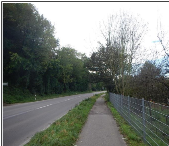
Karlsruher Straße Baulicher Radweg in unzureichender Breite
