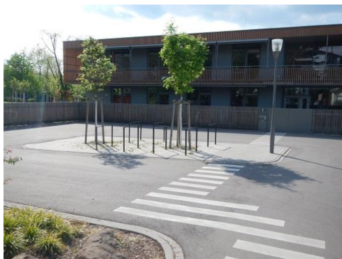
Abb. 8.14: Anforderungsgerechte Abstellanlage am Kinderhaus Merlin in der Nordstadt
