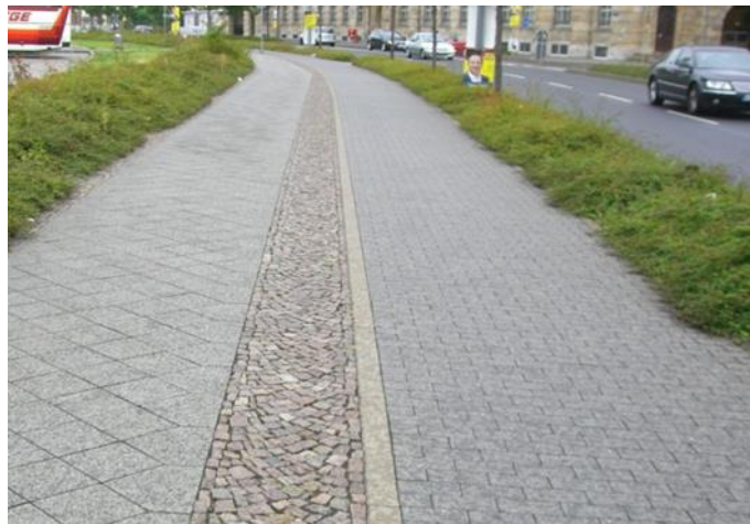
Abb. 4.1 Vom Gehweg getrennter Radweg (Beispiel Leipzig)
