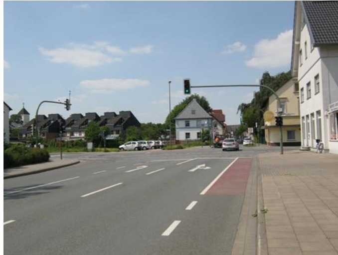
Abb. 4.14 Vorbeifahrstreifen in einer signalisierten Knotenpunktzufahrt (Bielefeld)
