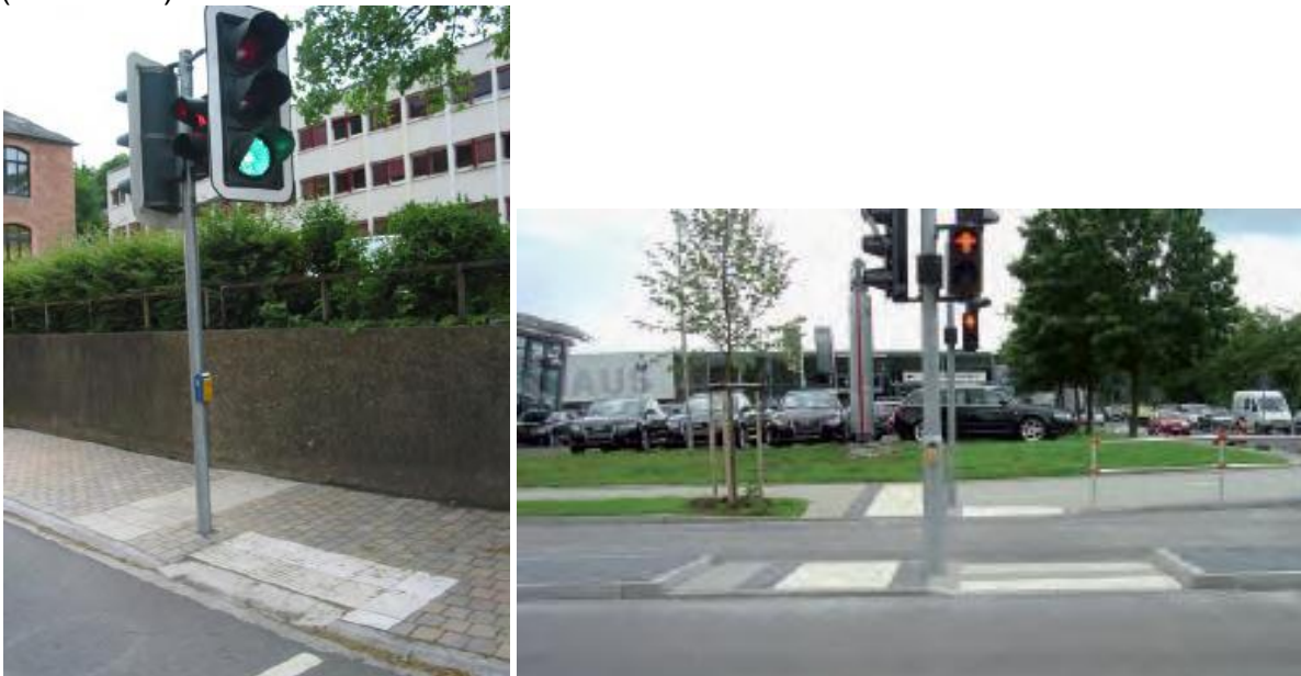
Bild : Getrennte und gleichzeitig gesicherte Querung
