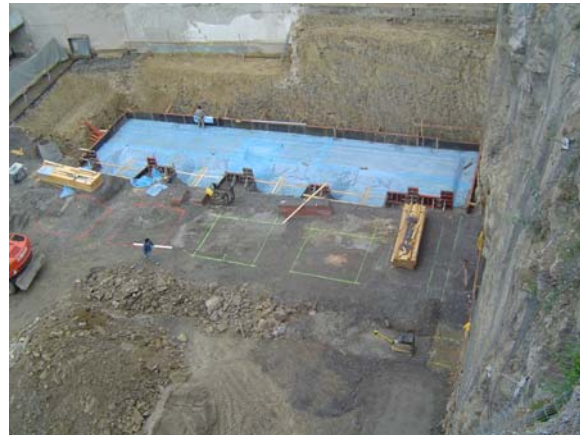
Fundamentarbeiten für Haus A am 30.05.2005
