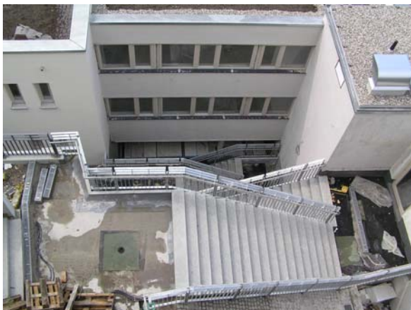
14.07.2006 Erstellen der Handläufe
