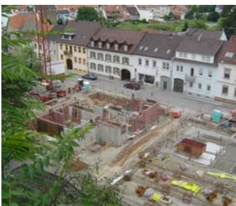
10.08.2005 Beton- und Fundamentarbeiten
