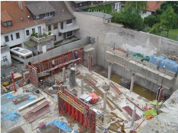
07.07.2005 Betonarbeiten im Garagengeschoss des Hauses A
